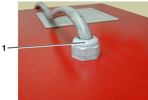
Faire attention que le câble n'entre pas accidentellement en contact avec des parties en mouvement ou fonctionnant à températures élevées, éventuellement, les bloquer avec des colliers. La section des conducteurs du câble d'alimentation (installé sur passerelles ouvertes et avec température ambiante maximale de 45°C), doit être la suivante:
